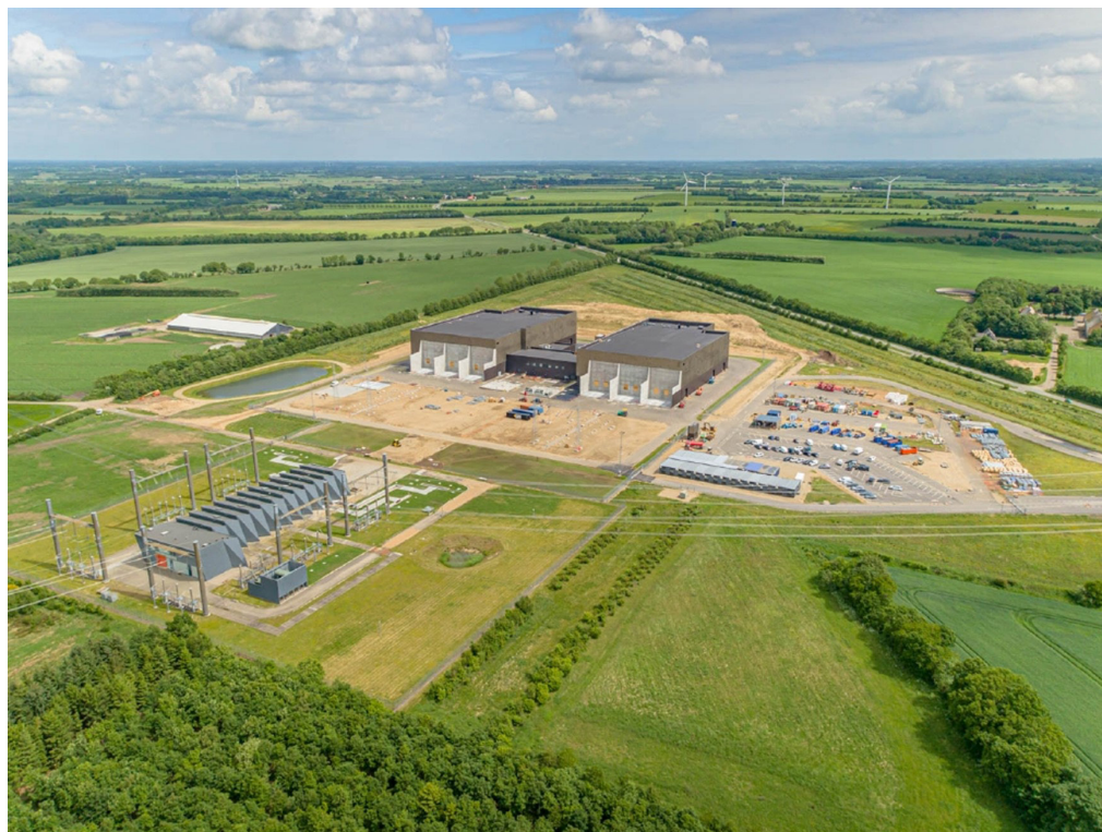
Figur 2.1. Eksempel på indretning af en højspændingsstation med konverterområde og 400 kV-område (GIS-bygning). (Foto fra Revsing station mellem Kolding og Vejen).
